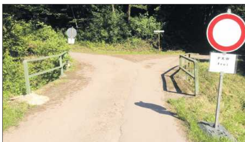
Schwere Fahrzeuge dürfen die Brücke nicht mehr benutzen, aus Angst, sie könnte einstürzen. FOTO: MOSCHEL
